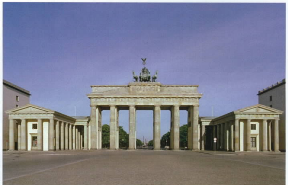
Das wohl bekannteste Bauwerk des schlesischen Baumeisters Carl Gotthard Langhans, das Brandenburger Tor in Berlin. Foto: Alexander Hartmann
