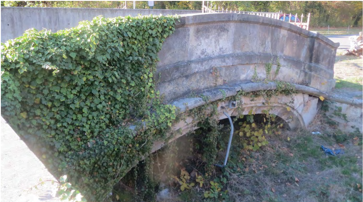
19 Potsdam, Neues Palais, ehemalige Brücke zum Palais auf der Nordseite
