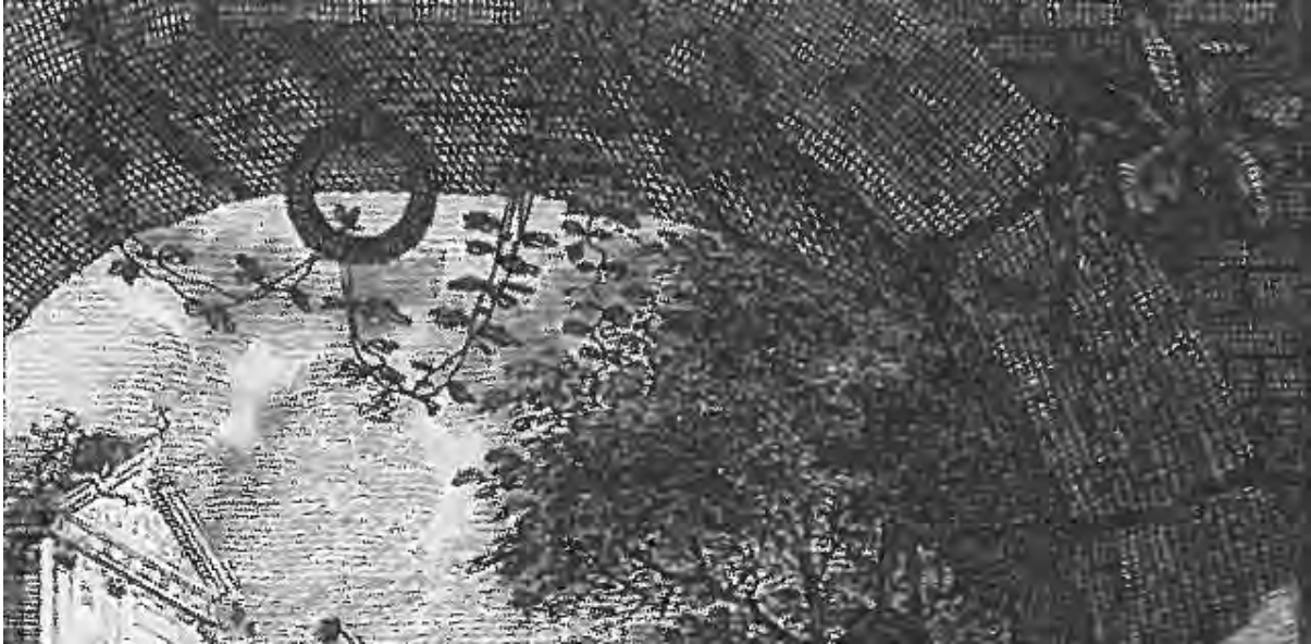
15.1. Les Francs-Maçons Écrasés, Detail: Bogen mit Schluss-Stein und Ring sowie Ziegelgewölbe
