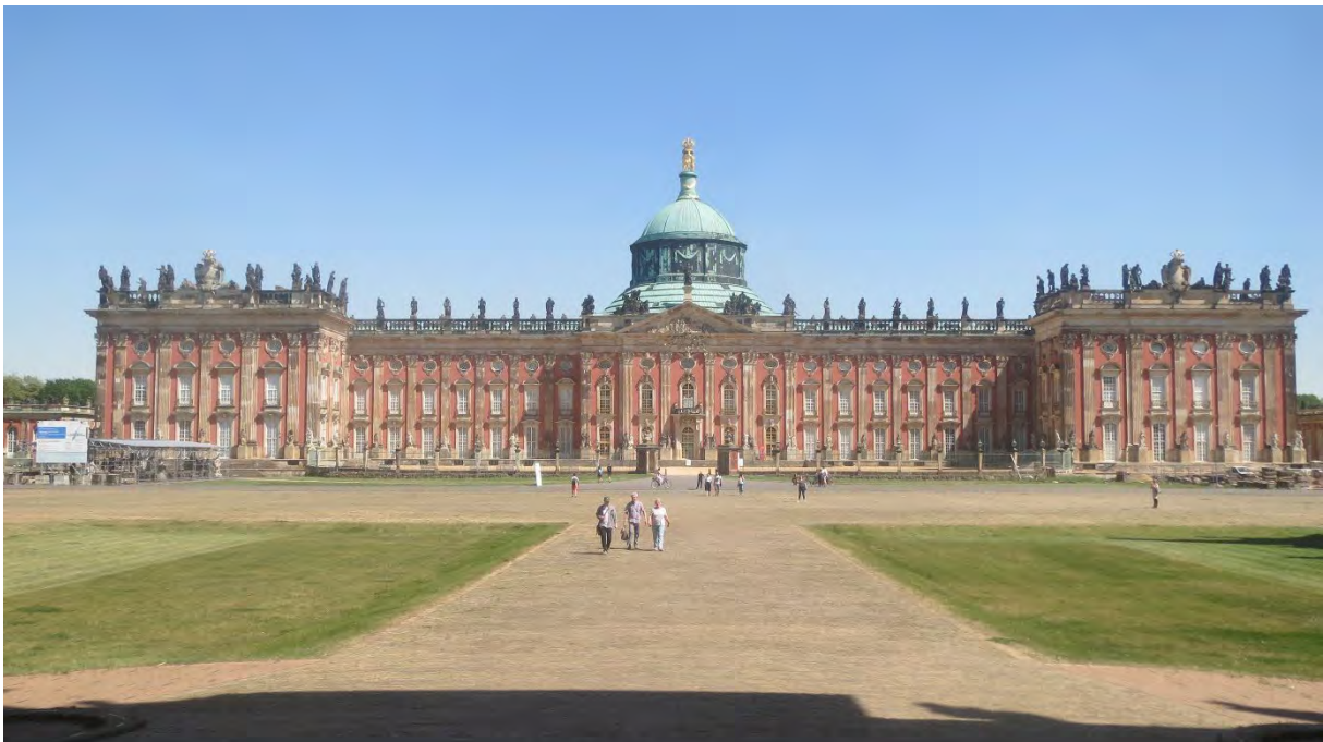
11 Potsdam, Neues Palais, Gesamtansicht von Westen
