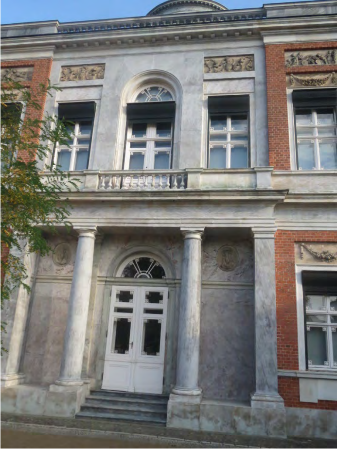
8 Potsdam, Neuer Garten, Marmorpalais, Säulen Eingangsseite
